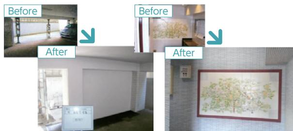
亀裂欠損の部分補修は、肌合せや調色に注力し自然な仕上がりを実現。タイル貼替では絵入りタイルのみを残して貼り換え。耐震改修では、構造計算に基づき柱と壁の増設、梁部分の補強を施しました。
