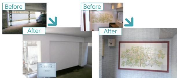
亀裂欠損の部分補修は、肌合わせや調色に注力し自然な仕上がりを実現。タイル貼替では絵入りタイルのみを残して貼り換え。耐震改修では、構造計算に基づき柱と壁の増設、梁部分の補強を施しました。
