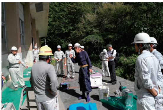
多能工育成プログラム(塗装改修工事編)の様子
