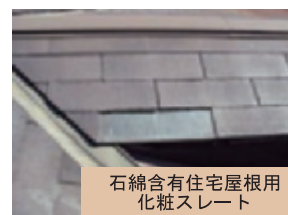
アスベスト含有建材の使用部位例
