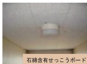
アスベスト含有建材の使用部位例
