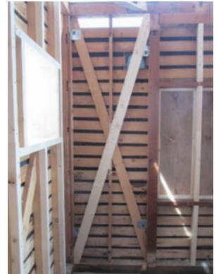
外壁の屋外側（左）と屋内側（右）それぞれに断熱材を施工。
