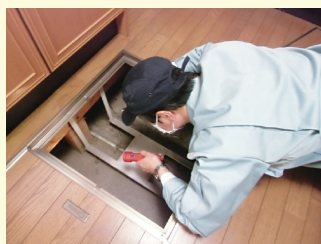
土台・床組・基礎調査
