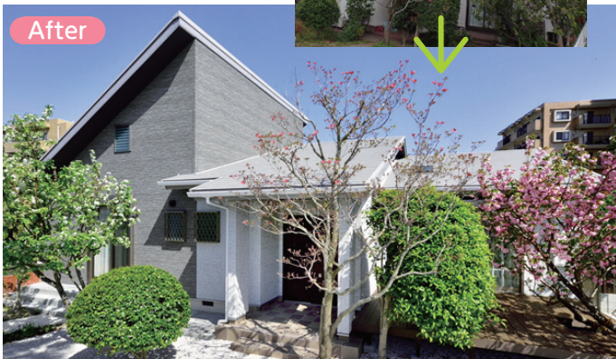
子どもが独立後に不要となった2階部分をなくし、高齢化に備えて 全ての生活空間を1階に集約した平屋への減築リフォーム。耐震・ 断熱改修も行き、安心で快適な住まいが実現しました。
