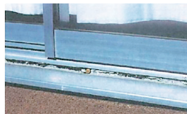
外壁・建具の周囲の劣化
