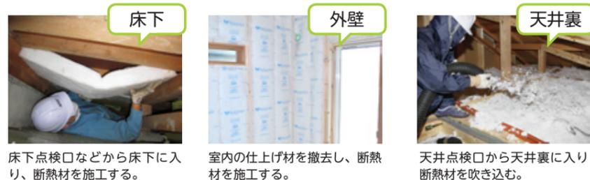
住宅の床下、壁、天井裏か小屋裏に断熱材を施工し、断熱性能を高めます。壁内部の結露を防ぐ処理も必要です。外壁の断熱改修は仕上げ材を撤去するなど大がかりになるため、耐震改修やその他のリフォームと同時に行うと効率的です。
