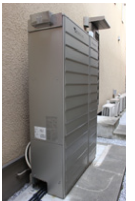
ガスで家庭用の電気とお湯の双方をつくる家庭用燃料電池コージェネレーションシステム(エネファーム)も。
