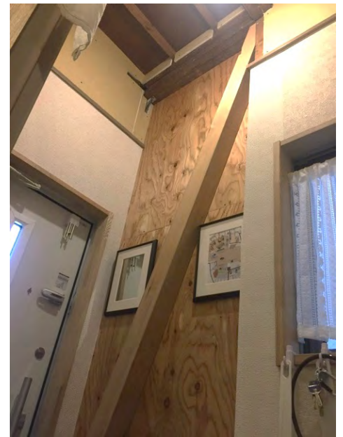
筋かい増設による耐震補強
