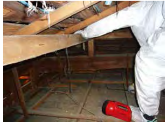
小屋裏の建物調査例
