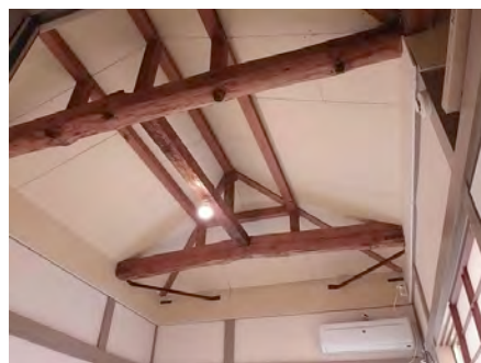
何も設置する予定がない天井であるため、押出法ポリスチレンフォーム3種を用いて小屋裏断熱補強を実施
