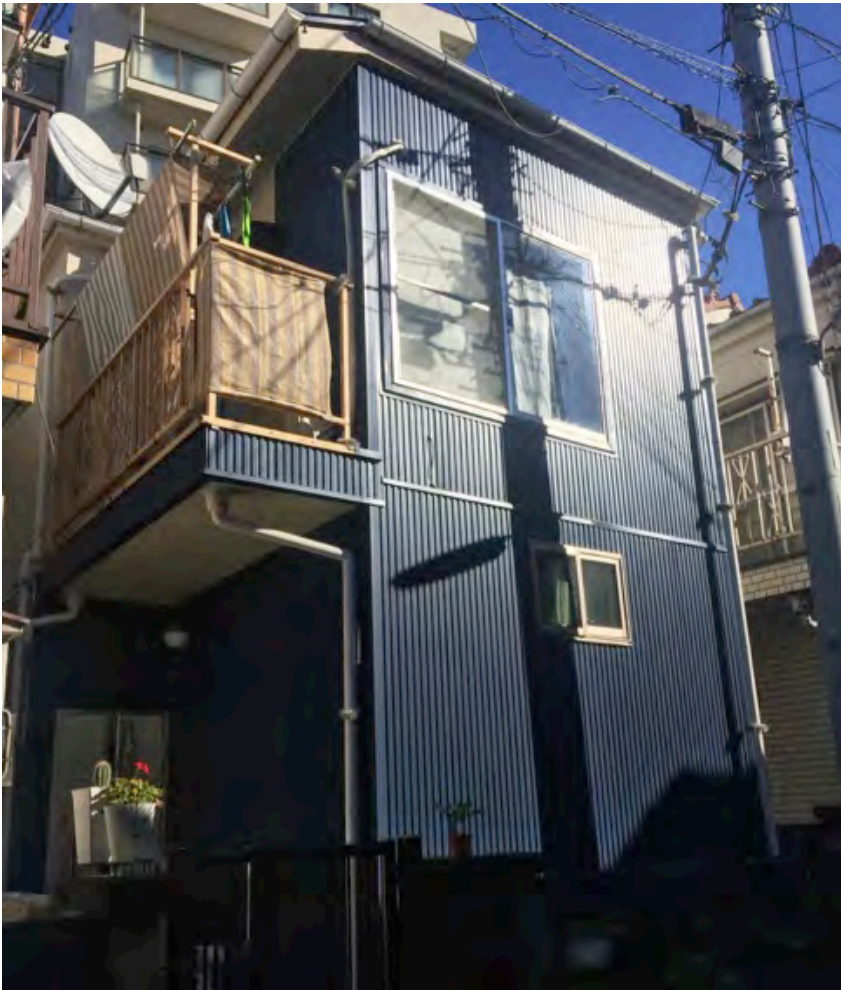
耐震補強工事を行った箇所はガリバリウム鋼板張りになっている
