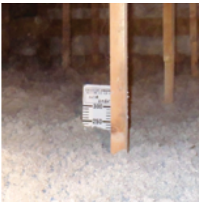
天井断熱の例（吹付断熱）
